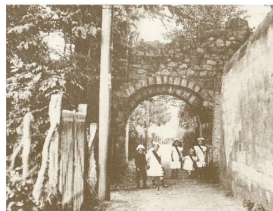
De brug over de Kerksteeg met muur
