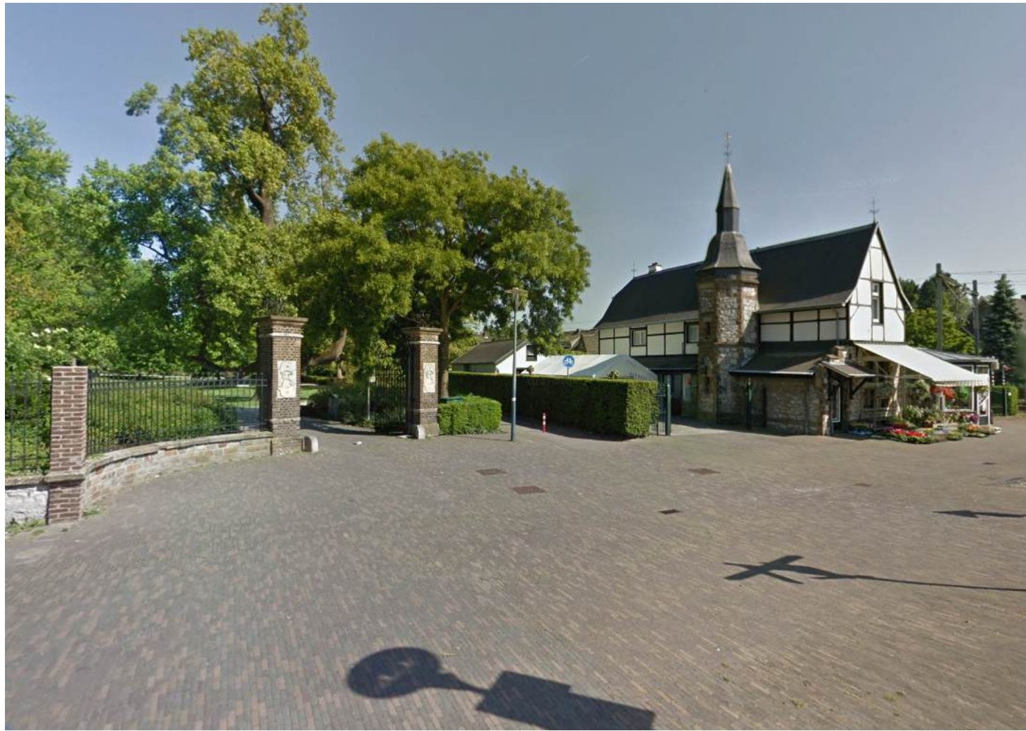
Figuur: Huidige toestand entree Proosdijpark met zicht op toegangspoort en Proosdijkapel.
