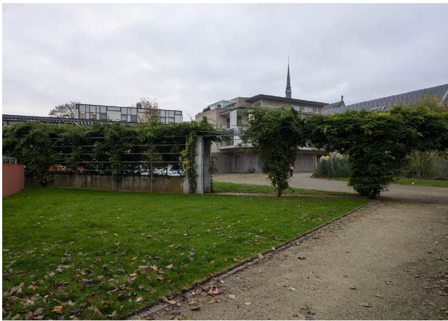
Figuur 4: Huidige toestand waarbij pergolaconstructie sterke scheiding vormt tussen Stationstraat en Proosdijpark
